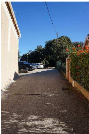
Rue du village dépourvue de dispositifs
